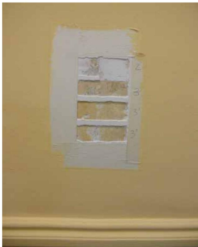
tes habían sido limpiados agresivamente, vueltos a revocar con una suerte de enduido de cemento y reiteradamente pintadas con diferentes recubrimientos, perdiéndose su autenticidad. Entonces se probaron diferentes procedimientos con el fin de despejar los paramentos, observándose que cuando se lograba retirar la totalidad de los recubrimientos, quedaba expuesto el símil piedra original erosionado, disgregado y fisurado.
