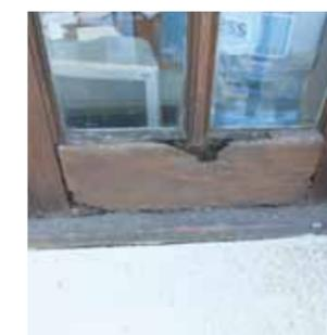
Detalle de una ventana mostrando la putrefacción de parte de sus elementos.
