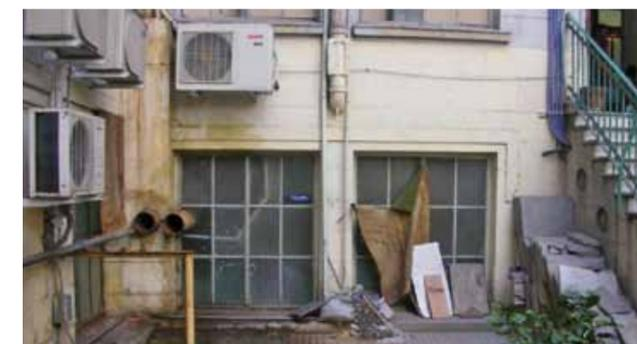
Uno de los frentes de la fachada exterior Norte del edificio de Paseo Colón 982. Se observa el enduido cementicio que, aplicado sobre el símil piedra original erosionado, se encuentra parcialmente desprendido.
